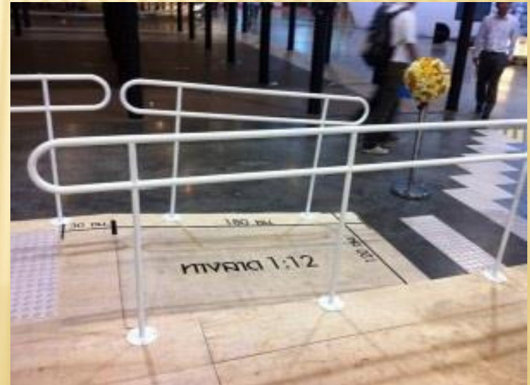
๘.๕ ติดตั้งราวจับ-ราวกันกระแทกอย่างมั่นคง
